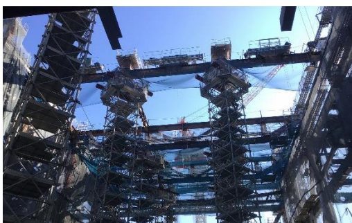
公共施設(大ホール部分)鉄骨工事状況
