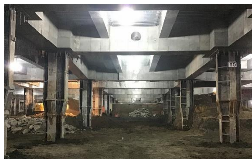
地下2階部分掘削工事状況
