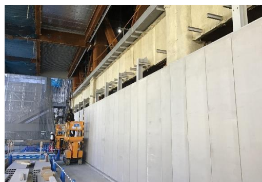
外装工事(ECP取付)状況
