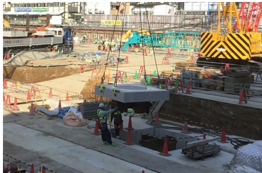
免震装置（免震PC）設置状況
