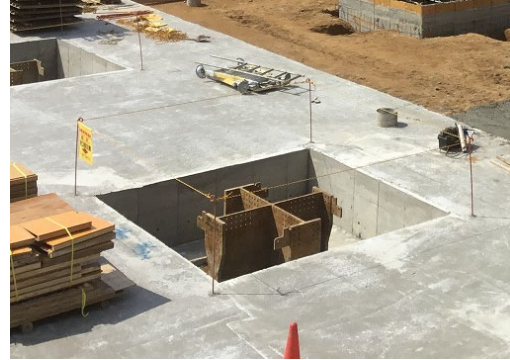
杭に打ち込んだ鉄骨柱頭部
