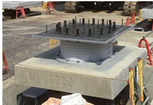
免震装置（免震ゴム）設置状況
