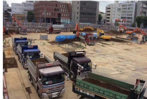
掘削に伴う発生土搬出車両
