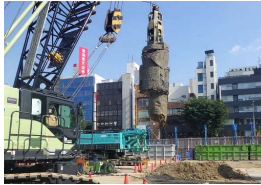
地中障害撤去・引揚
