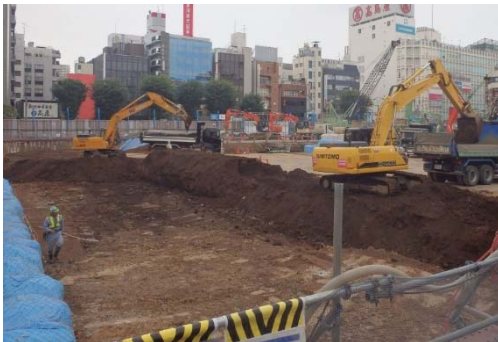
地下掘削(一次掘削)
