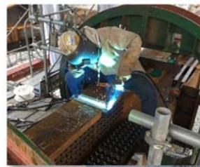
←構真柱の溶接
