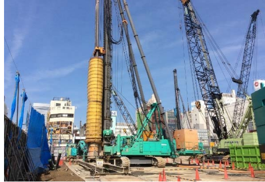
SMW機による山留壁施工
