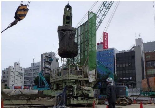
CD機による地中障害撤去
