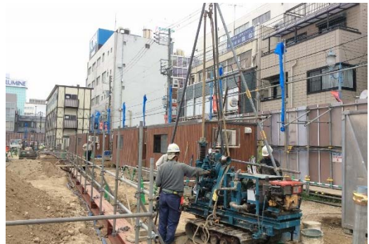
観測井戸掘削
